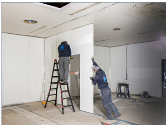
Costruzione box-in-box HygiWall liscia.
